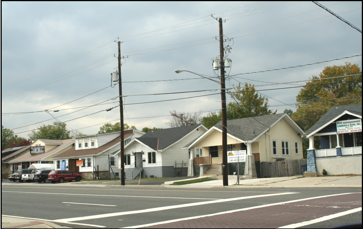
Looking west, 4022-4020-4016-4014-4012 Bladensburg Road ( EHT Traceries , 2007)
